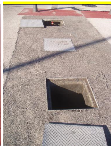
Decantadors de sòlids
