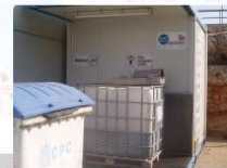
Fotografía del "punt blau" instalado
